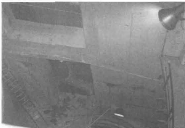
写真2 切断したコンクリート壁開口部の例
